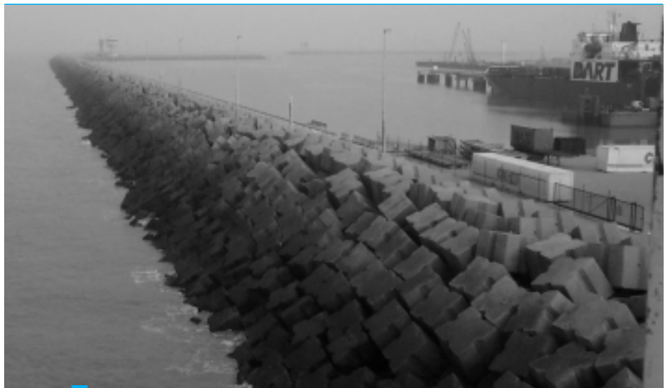
BV Gegroefde kubusvormige betonblokken vormen de deklaag van een deel van de westelijke strekdam te Zeebrugge
