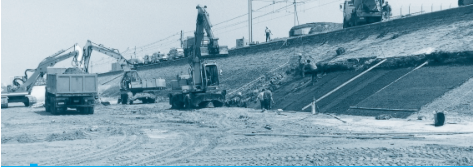
WWK Herstelwerkzaamheden aan de dijk van Raversijde
