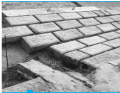
WWK De kern van een dijk wordt afgeschermd met behulp van betonblokken of andere materialen
